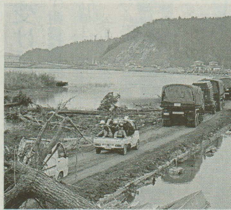
道路兼用堤防で交通路を確保—宮城県石巻市釜谷
