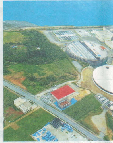
供用開始した新石川浄水場(提)
