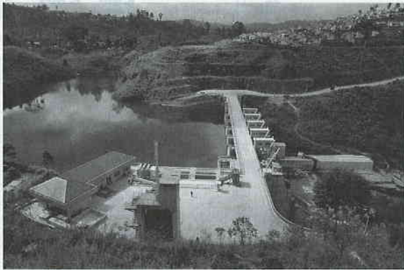
写真3 スリランカのアップパーコトマレ水力発電所建設事業 (写真提供: 村中達朗)
