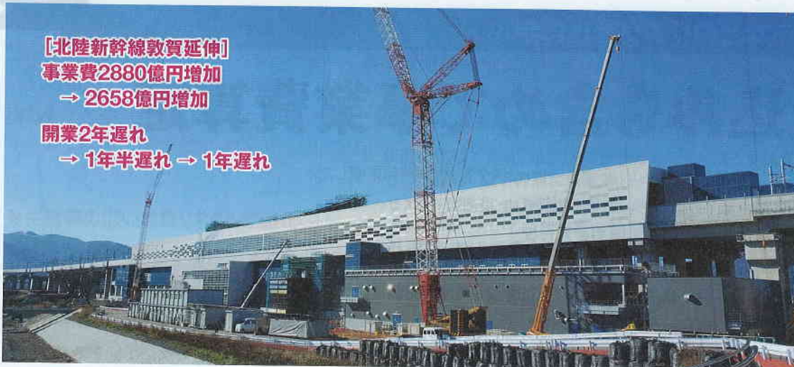
資料3 ■ 施工中の北陸新幹線の敦賀駅。3層構造に変更したことが、工期延長や事業費増大につながった (出所:鉄道建設・運輸施設整備支援機構の写真に日経クロステックが加筆)
